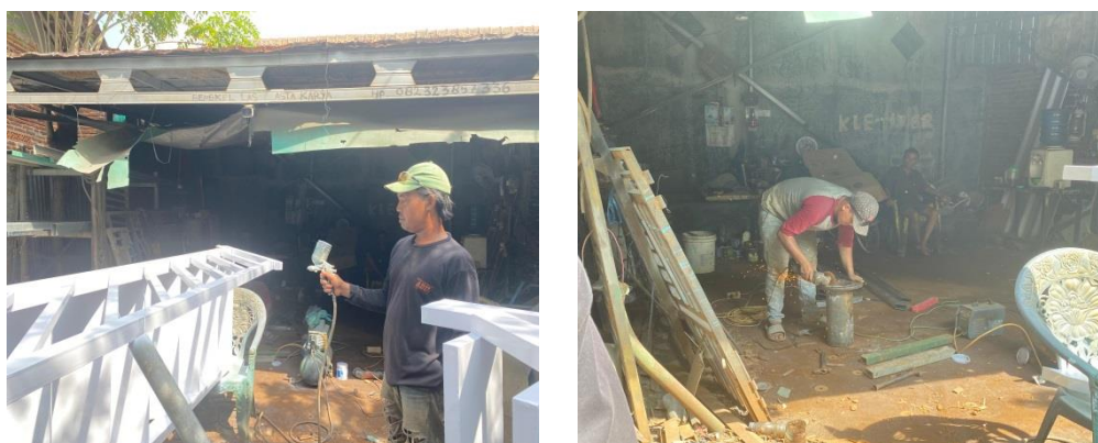
Gambar 4. Kondisi Pekerja sebelum menggunakan APD
